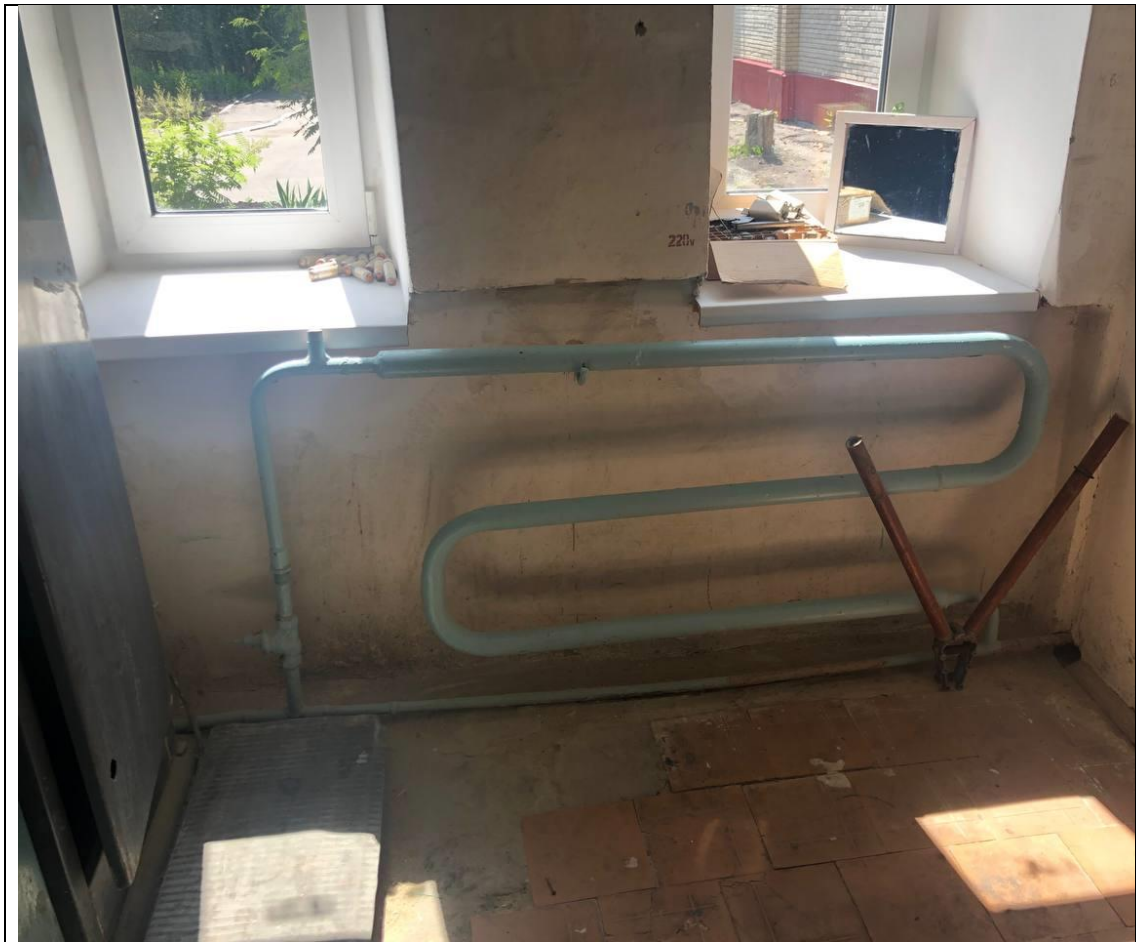
Дефекты напольно й плитки
